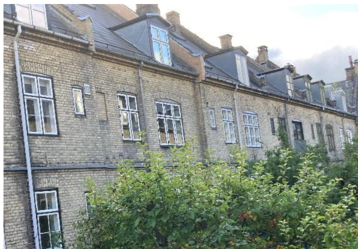
Vinduer i rækkehus, gårdfacade
