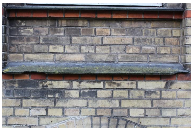
Fugeprofil på gadesiden
